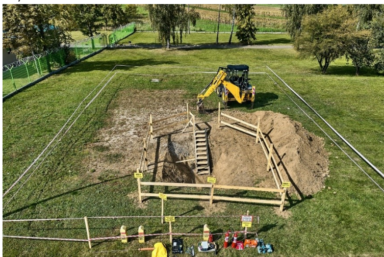
Rysunek 4 Przykład wygradzenia, oznakowania i zabezpieczenia strefy pracy podczas realizacji prac ziemnych
